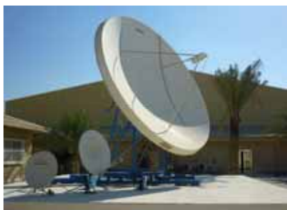
Antenne GEOLUT de la station sol des Émirats Arabes Unis (AEMCC)
