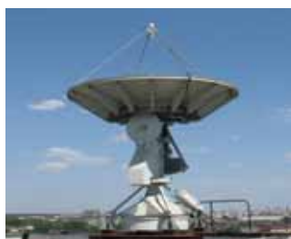
Antenne MEOLUT de la nouvelle station russe
