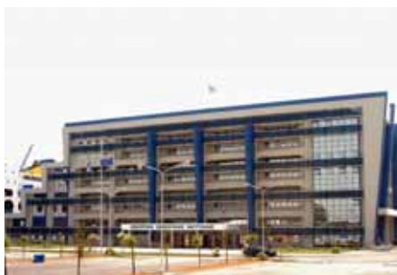
Le nouveau MCC de la Grèce, situé dans l'immeuble du Ministère de la Marine Marchande, de la Politique Égéeenne et des Îles, Port du Pirée, a atteint le statut FOC en janvier 2008.
